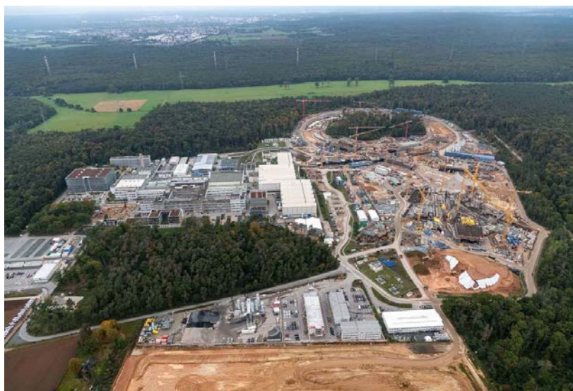
Vista aérea del estado de avance de la obra civil del proyecto FAIR. La construcción de la HEC (High Energy Cave) que albergará el experimento R3B está muy avanzada
