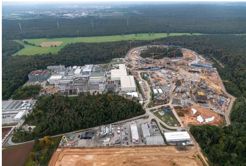
Figura 1. Vista aérea del estado de avance de la obra civil del proyecto FAIR. La construcción de la HEC (High Energy Cave) que albergará el experimento R3B está muy avanzada
