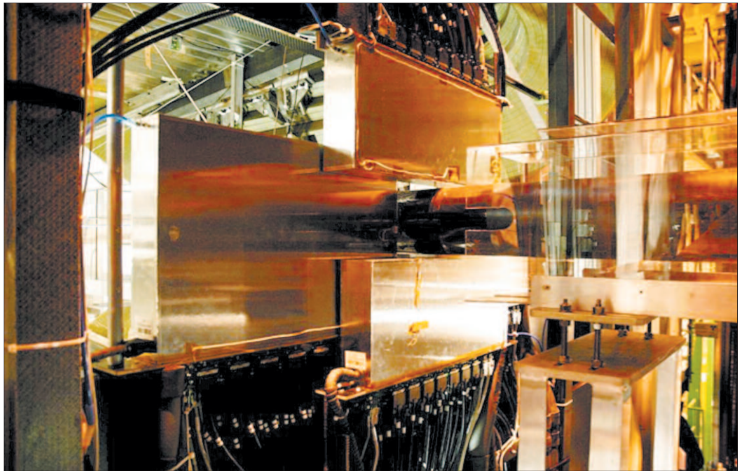
Fotografía de una de las tres estaciones de micropistas de Silicio del Inner Tracker de LHCb construido por la Universidad de Santiago de Compostela y la Universidad de Lausanne, tras su instalación en el LHC del CERN en 2009. El detector consta de 300.000 canales electrónicos. Puede verse en la foto el tubo horizontal del sistema de vacío del acelerador por donde circulan protones de energía de colisión 7 TeV.
